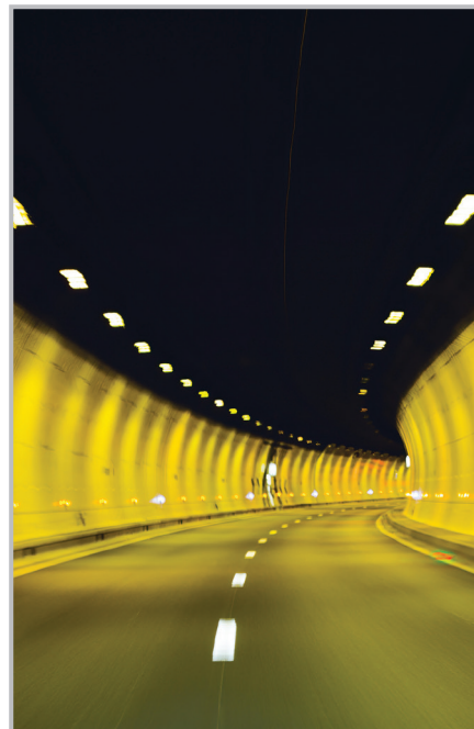
TETA کنترل روشنایی تونل‌ها
